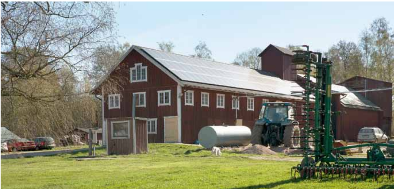
På Åskekärrens Gård utanför Töreboda har Per-Anders och Monika Didriksson byggt solceller på ladugårdstaket. Elen används till ventilationen i svinstallarna och överskottet säljer de. Foto: Diakrit
